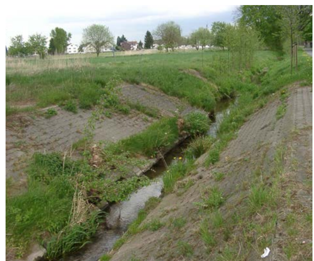
[Bild 2 oben: Rodau zwischen Urberach und Ober-Roden; Bild 3 unten: Kanalartiger Ausbau]
